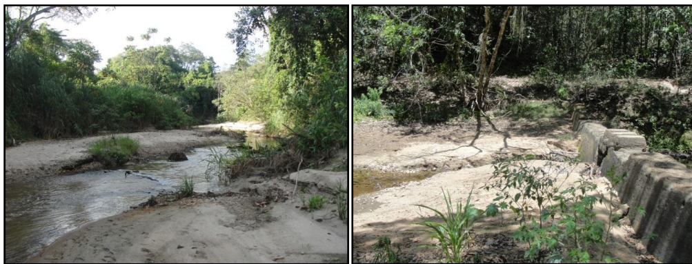
Figuras 20 e 21. Assoreamento do rio Brandão e da barragem no interior da UC (Fotos de Márcia Porto).
