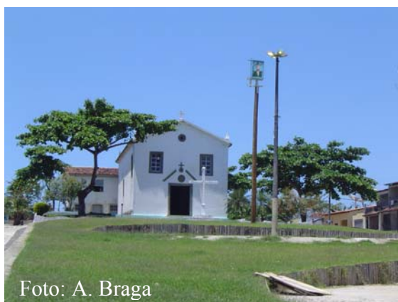
Figura 10. Igreja Nossa Senhora da Escada, distrito de Olivença (Ilhéus)
