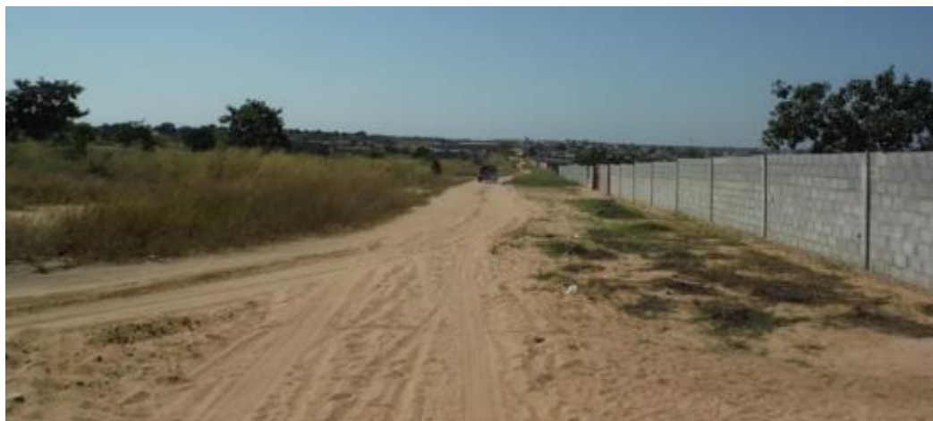
Imagem 2.28: Alinhamento da Tubagem a Norte de Alvarenga
