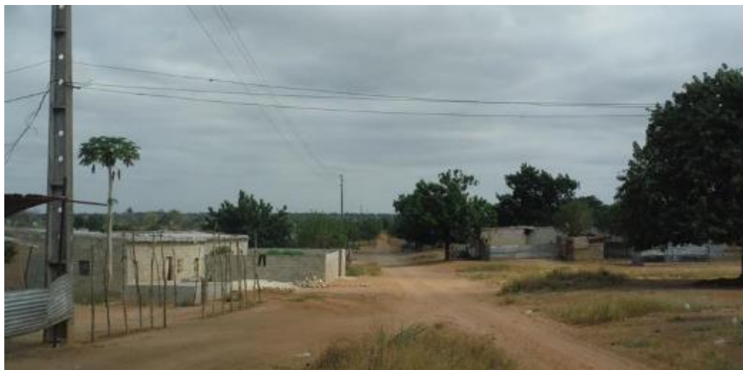
Imagem 2.4: Encaminhamento da Tubagem Através da Aldeia de Júlio
