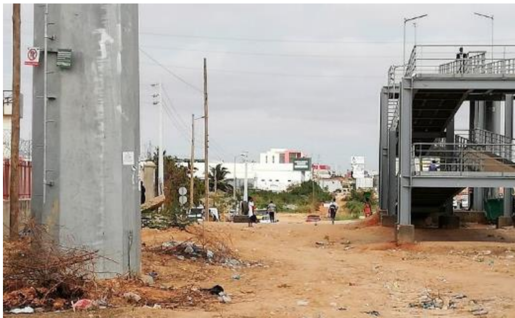
Imagem 2.22: Construção no Cruzamento com a Via Expresso
