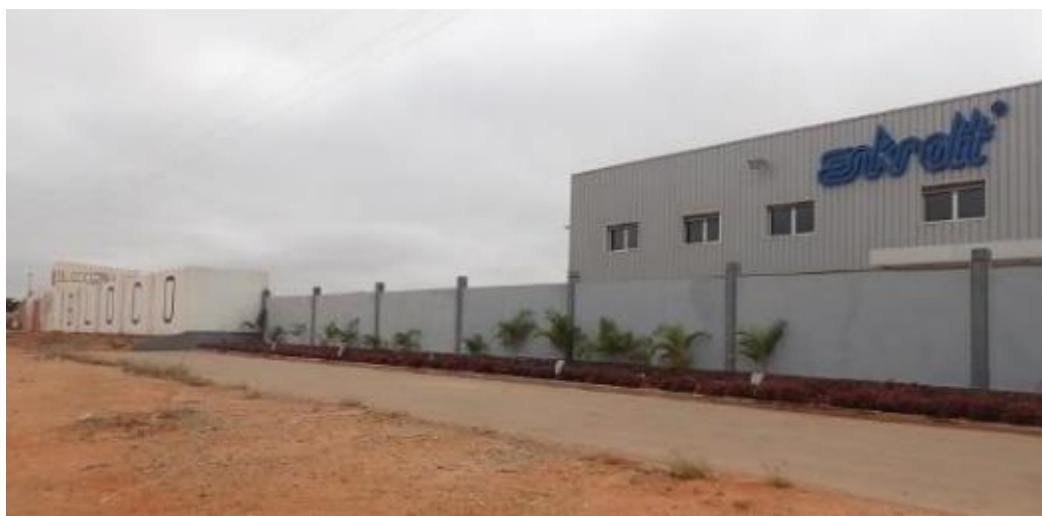
Imagem 2.21: Instalações Industriais no Alinhamento do Nó 2 ao CD de Benfica II.
