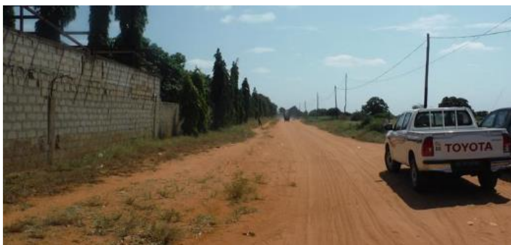
Imagem 2.8: Vista na Direcção Norte do Alinhamento dos Tubos Provenientes do Terreno das Instalações do Bitá
