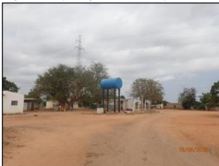
Imagem 6.9: Tanque de Água Elevado de Propriedade Privada no Assentamento de Alvarenga, Área de Serviço Mundial.
