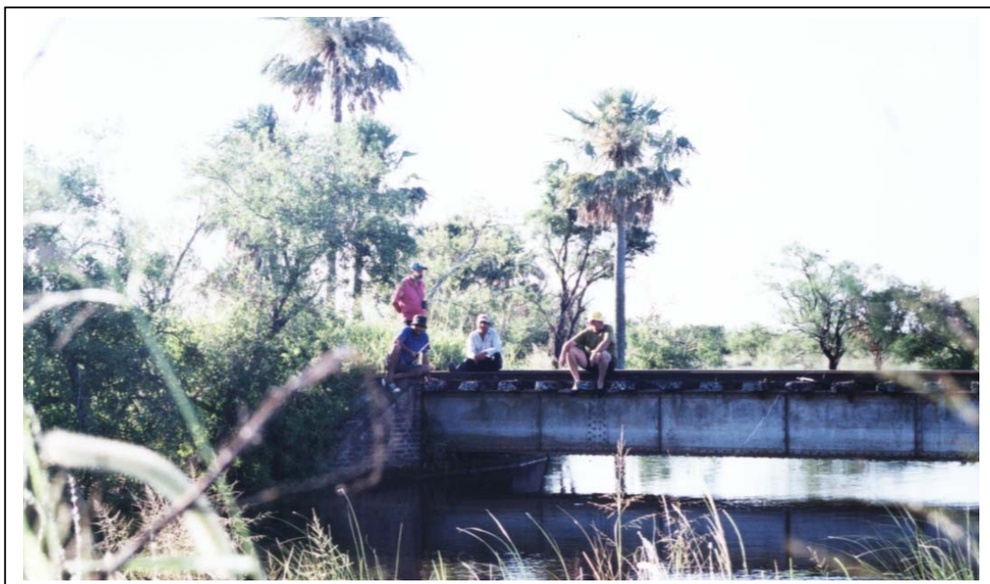
Foto N° 19: Riacho Tapenagá – Puente vial
