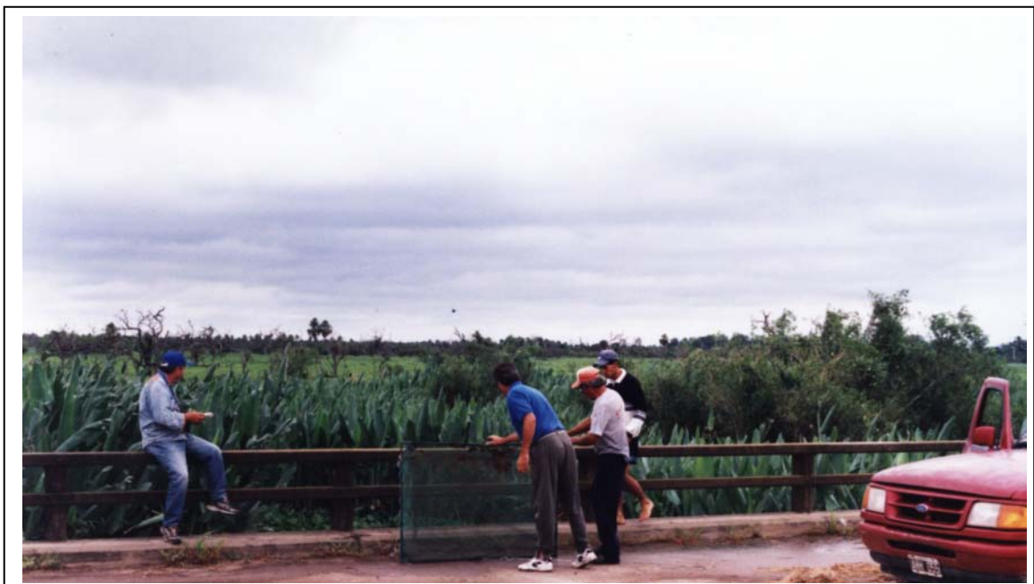
Foto N° 30: Puente sobre el Arroyo Palometa
