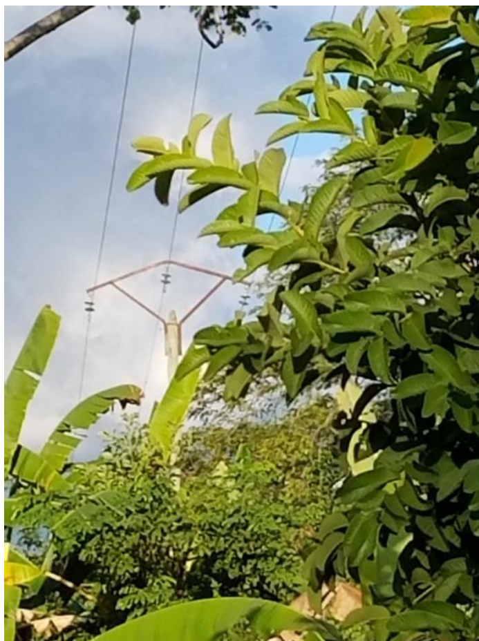
PHOTO 4-1: LIGNE EXISTANTE (AMBANJA) A REHABILITER
