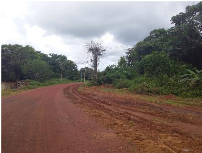
Photo 54: Vue de lampadaires solaires en bordure de voie à Motobo 1 Source : BNETD, Enquête socio-économique, Octobre – Novembre 2019.
