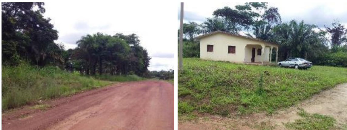
Photos 41 et 42: Vues de la configuration de l'habitat et du logement d'instituteur à Venez-voir Source : BNETD, Enquête socio-économique, Octobre – Novembre 2019.
