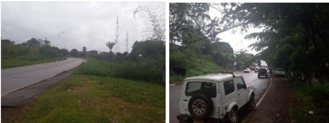
Photo 31 et photo 32: Vues du poste et réseau électriques riverains du projet dans le 4 ème Arrondissement de la Commune de Franceville
