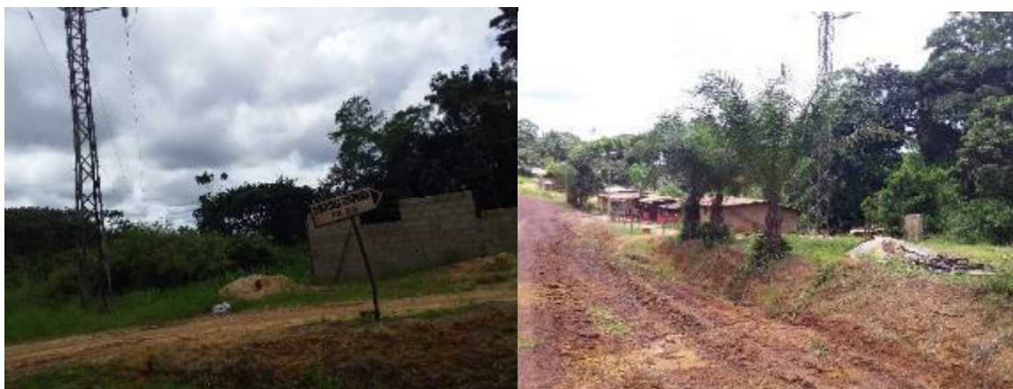
Photos 45 et 46 : Vues des constructions alignées sur un côté (à gauche ou à droite selon le sens considéré) de la route qui traverse le village de Mbouma et d'Ondama.
