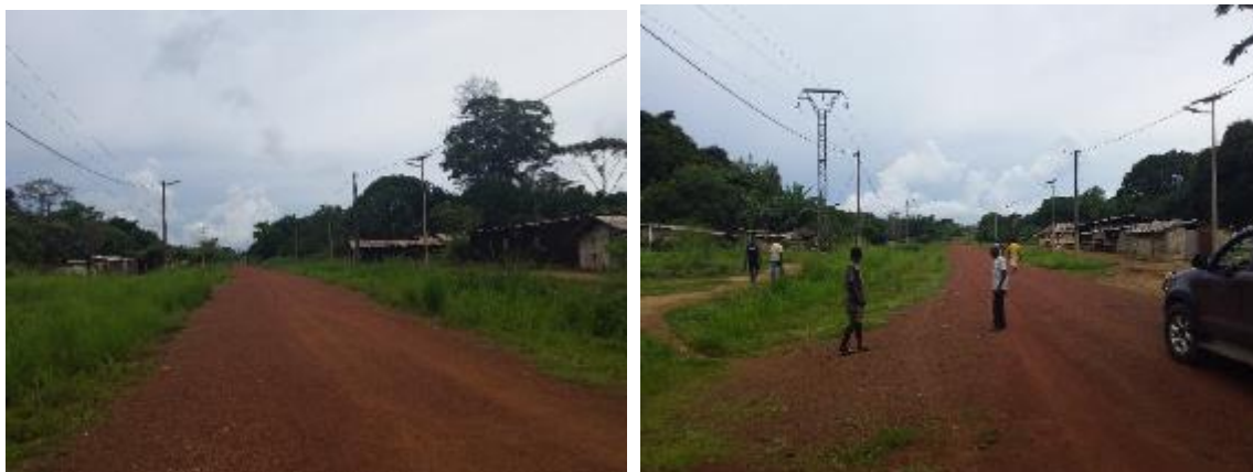
Photos 88 et 89 : Vues de poteaux en béton du réseau BT alimenté par un groupe électrogène et de lampadaires solaires à Andjogo
