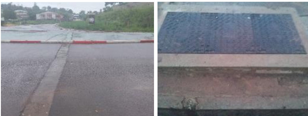
Photo 27 et photo 28 : Vues de trace et d'équipement marquant l'existence de réseaux le long de la route concernée par le projet
