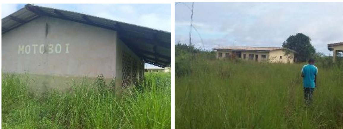
Photos 52 et 53 : Vues de l'école primaire et du dispensaire abandonnés dans les herbes
