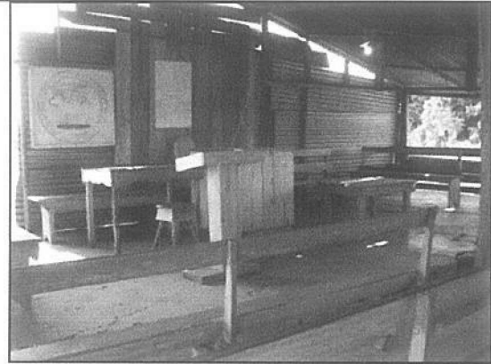
Interior de la Iglesia existente
