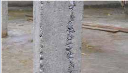
図 3.5 コンクリートの気泡のようなキズで手抜き工事がわかる
