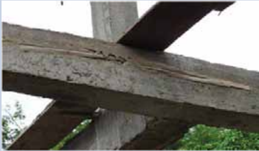
図 3.4 コンクリートの支持梁に埋もれた破片の屑
