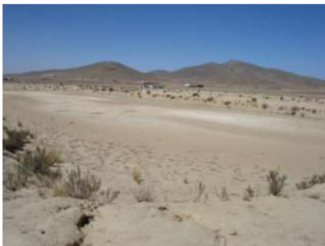
Foto 3. Laguna de estabilización construida desde 1990 sin concluir hasta la fecha
