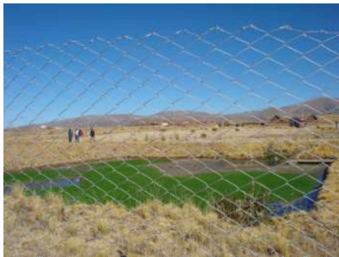
Foto 7. Planta de tratamiento de Tiahuanacu, 2007
