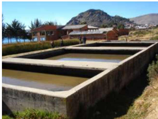
Foto 4. Primera planta de tratamiento Copacabana, 2007
