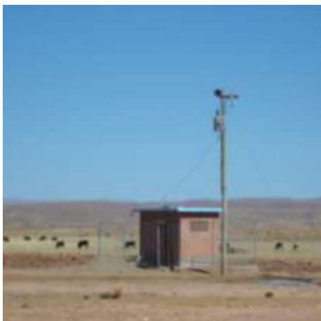
Foto . Caseta de la bomba de impulsión
