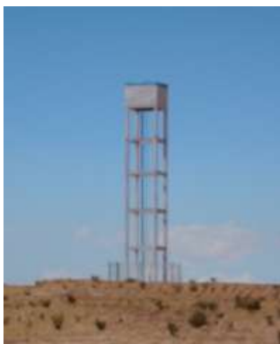
Foto . Tanque elevado de reservorio de agua bombeada desde el pozo, 2007
