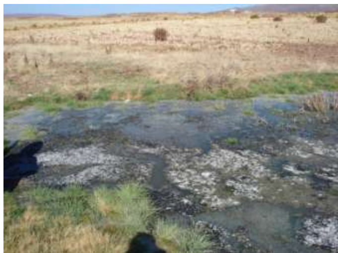
Foto 8. Agua estancada en el ingreso a la planta de tratamiento de aguas servidas, 2007
