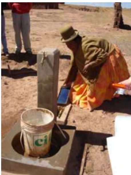
Foto . Pila de agua potable y su medidor de agua, 2007
