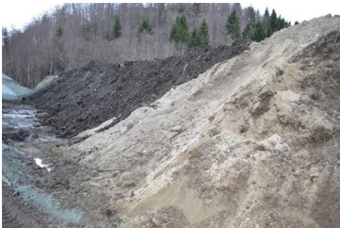
Figur 9-2: Bildet viser slik blanding av torv og sand i en jordranke. Det som skjer i denne prosessen er at vannet i torva frigis (se vannet som flyter ut ved bunnen av ranken til venstre i bildet under), og det organiske materiale fra torva blir liggende mellom sandkorna i blandingen. Selv om det skjer en stor volumendring, skyldes det bare at vannet frigjøres og har ingenting med nedbrytning av det organiske materialet i torva å gjøre. Foto: Trond Knapp Haraldsen, NIBIO
