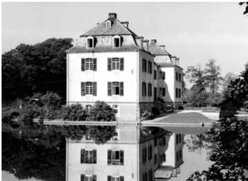
Außenansicht Haus Hall
