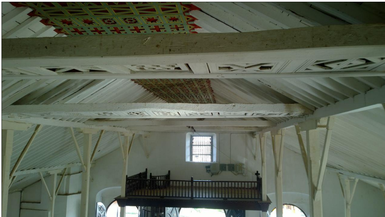
Foto #4. -Vista general de la estructura de cubierta de la iglesia. Se puede apreciar el Almizate en la parte superior, los pares o alfardas, los tirantes dobles decorados, las carreras de madera sobre las zapatas, los jabalcones o tornapuntas y las columnas de madera (Cortesía de Arq. R. Romero).
