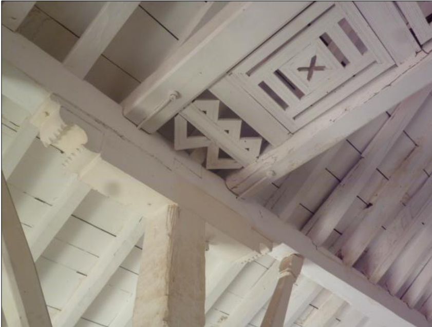
Foto #5. - Ampliación donde se aprecia la terminación de las zapatas en fauces abiertas, de los tirantes dobles decorados, de la carrera de madera y de los jabalcones que la soportan (D. Varela)
