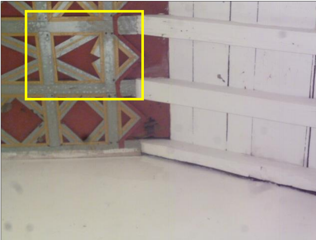
Foto #8. -Fotografía donde se puede apreciar el ataque de hongos xilófagos en el Almizate, los cuales producen la “pudrición blanca”. Nótese la decoloración en las lacerías y otros elementos. (D. Varela)
