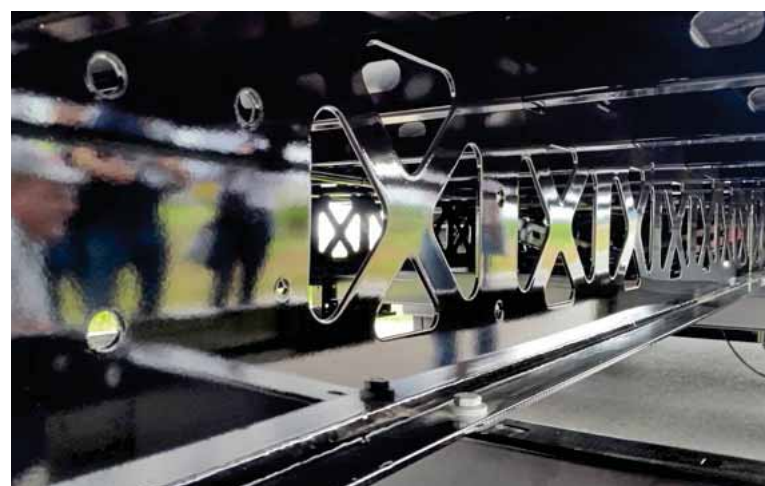
Stahl kommt nur dort zum Einsatz, wo es die Stabilität erfordert.
