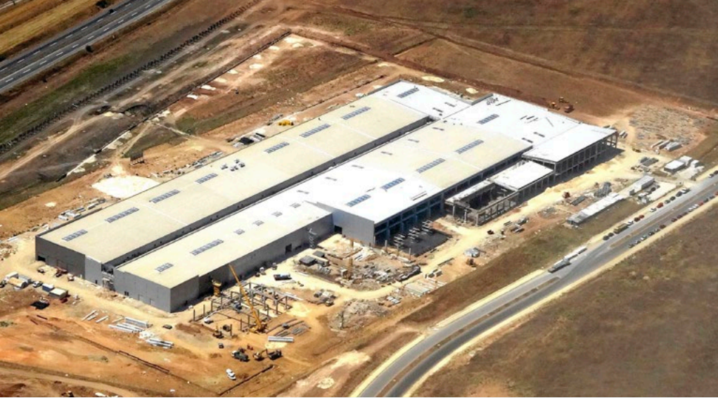
In nur einem Jahr hat Van Hool die vier Hektar große Fabrik in der Nähe von Skopje gebaut.
