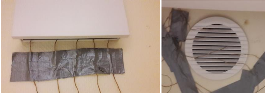
Abbildung 56: Platzierung der Temperaturfühler bei Gerät A innen und außen
