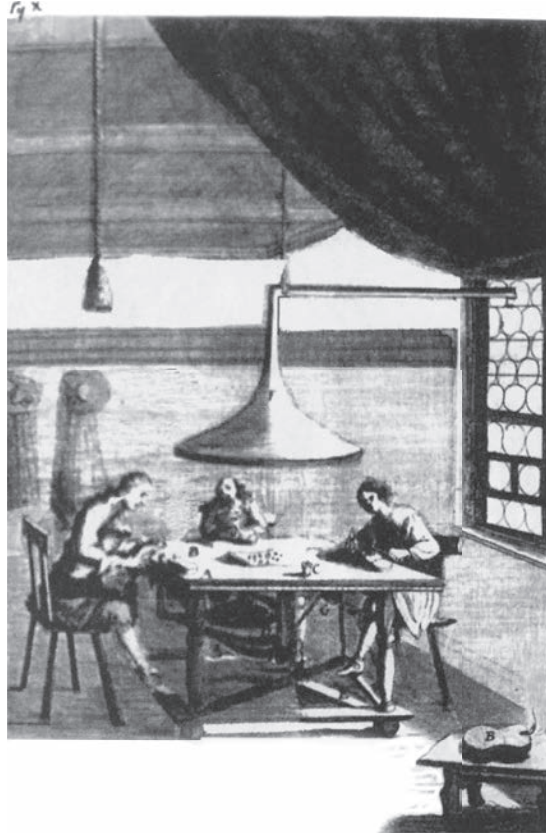
شكل ٤-١٣: تصنيع دُمى الزجاج الصغيرة بمساعدة منفاخ يدار بدواسة (من كتاب نوكل «أسلوب تجريبي في صناعة الزجاج» الصادر عام ١٦٧٩، بإذن من مؤسسة التراث الكيميائي).
