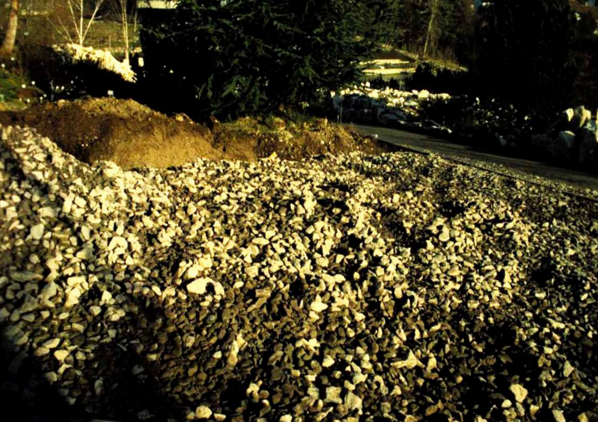
Großbaustelle geographisches Alpinum: Balkan, Vorderer Orient
