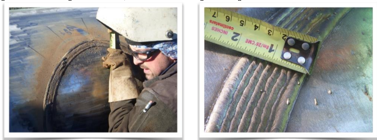
Bild 13. Anschweißen eines Pipelineabzweiges an einer Gasrohrleitung unter Betrieb
