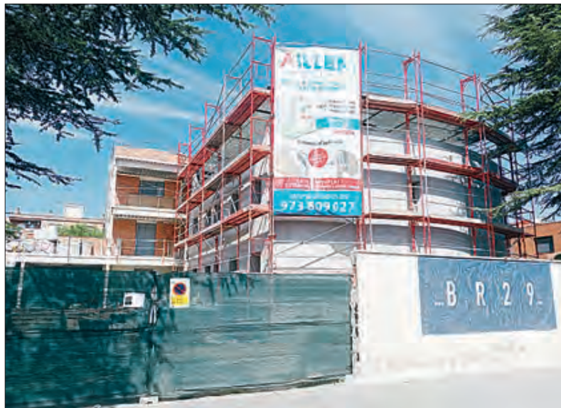
FOTO: D.A. / Edifici en obres del futur centre residencial de Sant Joan de Déu a la Bordeta
