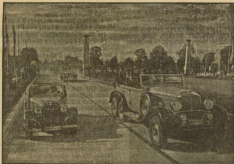
Reichsautobahn Frankfurt—Mannheim—Heidelberg fertig. Hoch. Hoffmann (M) Besichtigungsfahrt der neuen Strecke Frankfurt—Heidelberg, die nach genau zweijähriger Bauzeit fertiggestellt wurde. Im vorderen Wagen der Generalinspektion für das deutsche Straßenwesen, Dr.-Ing. Toth
