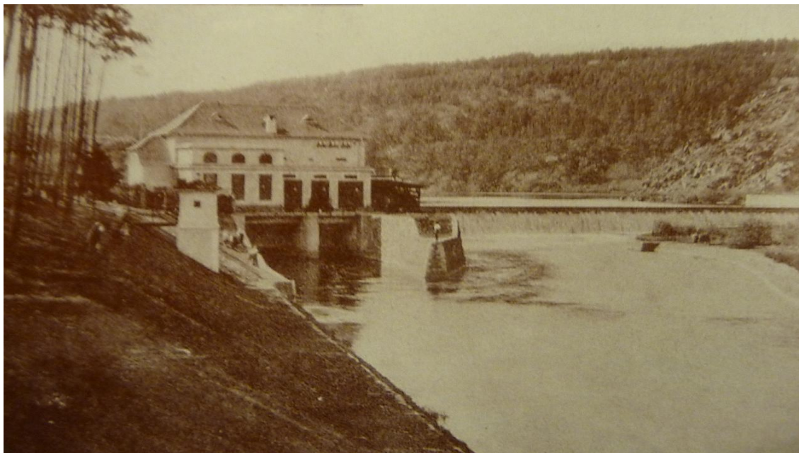
Obr. č. 10. Vodní elektrárna u Pňovan. Zdroj: Pecák, 2009
