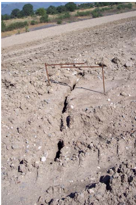
Εικόνα 66: Αστάθεια εδαφών, μετακίνηση πρανών υλικών
