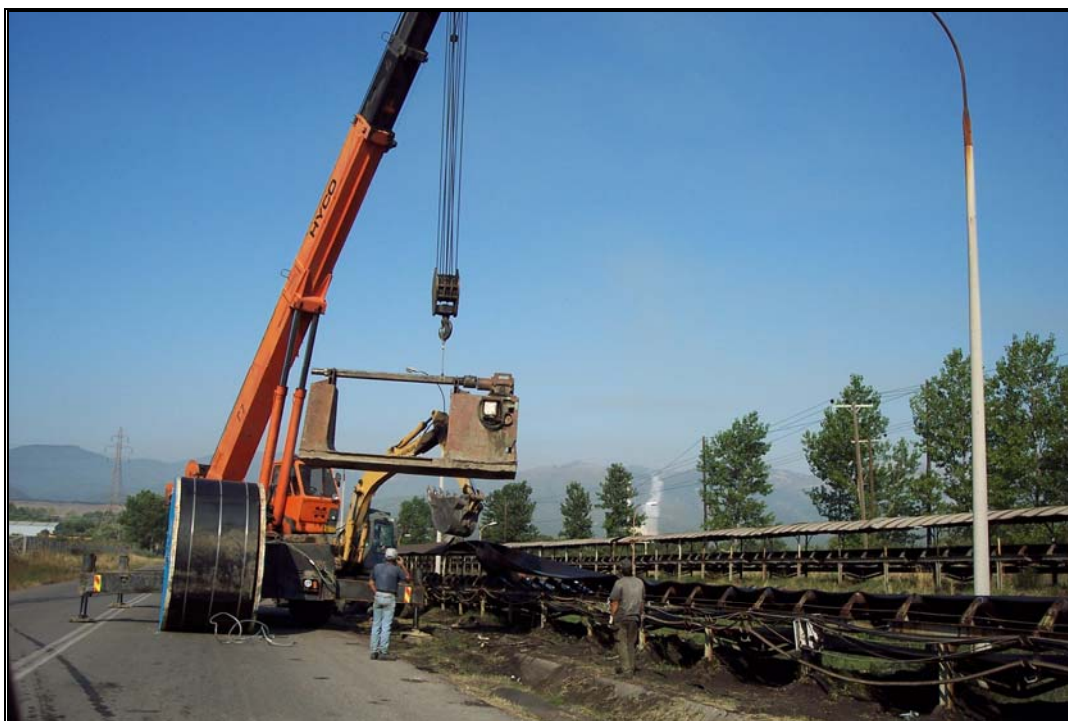
Εικόνα 69: Επισκευή ταινιοδρομων
