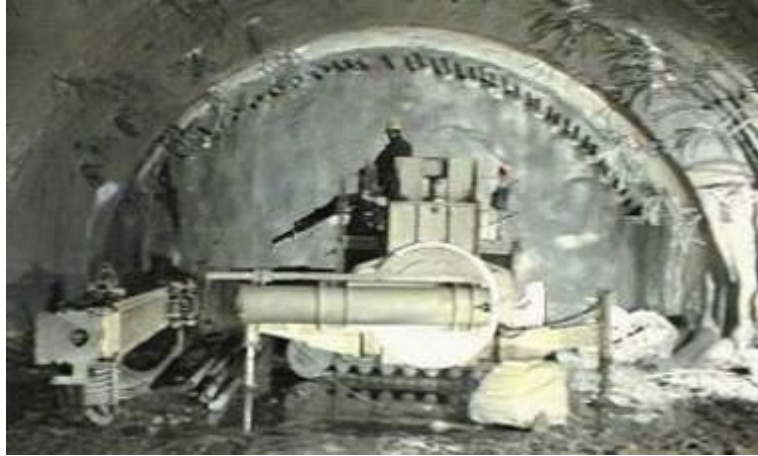
Σχήμα 1.16: Εφαρμογή δοκών προπορείας (Κατασκευή ομπρέλας) Figure 1.16: Forepoling implementation inside the tunnel (Umbrella construction)
