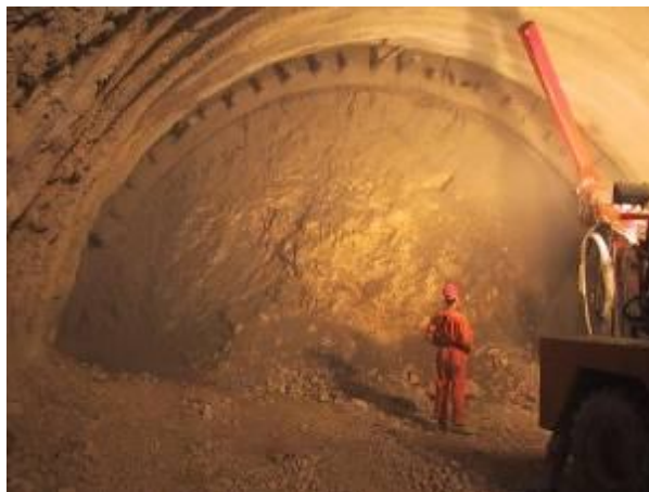
Σχήμα 1.29: Ρήψη εκτοξευόμενου σκυροδέματος
