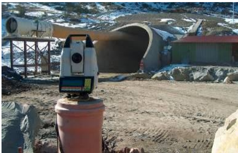
Σχήμα 2.25: Γεωμετρικός έλεγχος της τελικής επένδυσης του στομίου της σήραγγας
