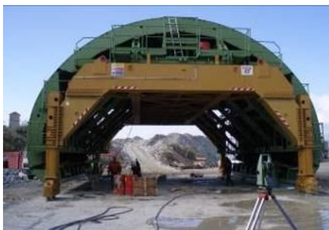
Σχήμα 2.22: Μεταλλότυπος θόλου Figure 2.22: Metal formwork
