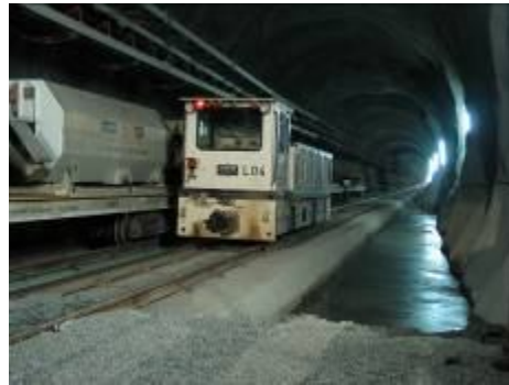
Σχήμα 1.2: Σήραγγα που θα χρησιμοποιηθεί ως αγωγός υδάτων
