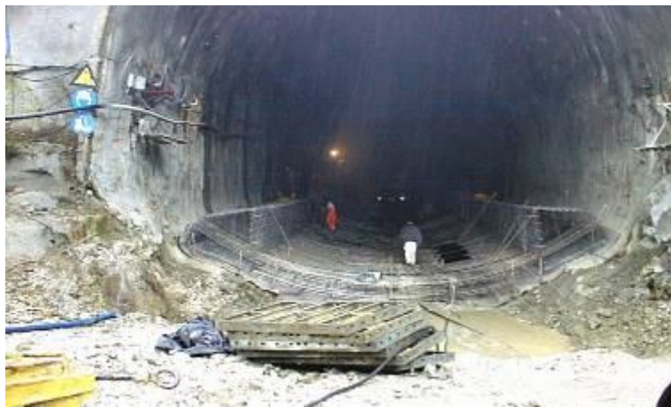
Σχήμα 1.14: Τοποθέτηση οπλισμού ανεστραμμένου τόξου
