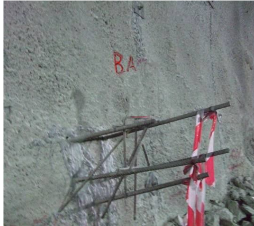
Σχήμα 2.7: Στάση με αγκυρωμένες ράβδους χάλυβα κι ενεματώσεις τσιμέντου
