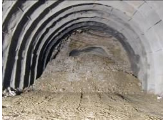
Σχήμα 2.13: Πέρασ διάνοιξης σήραγγας
