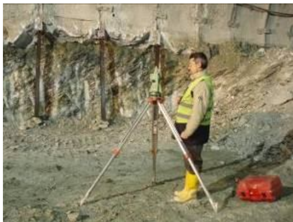
Σχήμα 2.21: Έλεγχος εκσκαφής και ποδαρικών στην Β' Φάση Figure 2.21: Geometric control of excavation at B' Phase
