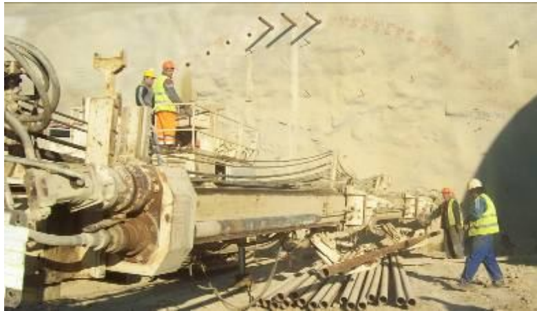
Σχήμα 1.17: Δοκοί προπορείας στο στόμιο της σήραγγας T1, Τέμπη Figure 1.17: Forepoling elements at the portal of the tunnel T1, Tempri
