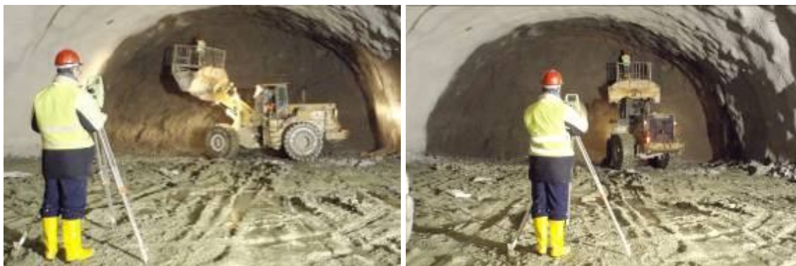
Σχήμα 2.20: Φάσεις χάραξης γραμμής διάτρησης. Διακρίνεται η κόκκινη γραμμή εκσκαφής Figure 2.20: Phases of drawing the drilling line. The red line indicates the excavation boundary
