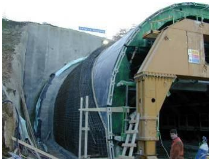
Σχήμα 2.24: Το καλούπι με τον φέροντα οπλισμό του Figure 2.24: The metal formwork with its bearing reinforcement
