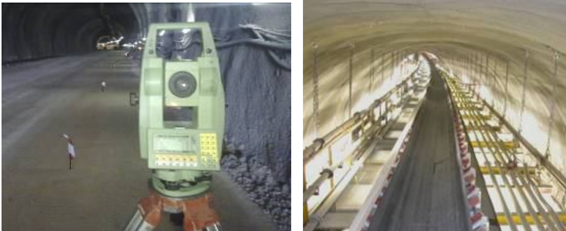
Σχήμα 4.2: Αριστερά: Οριοθέτηση πεζοδρομίων Δεξιά: Τοποθέτηση αγωγών αερίου
