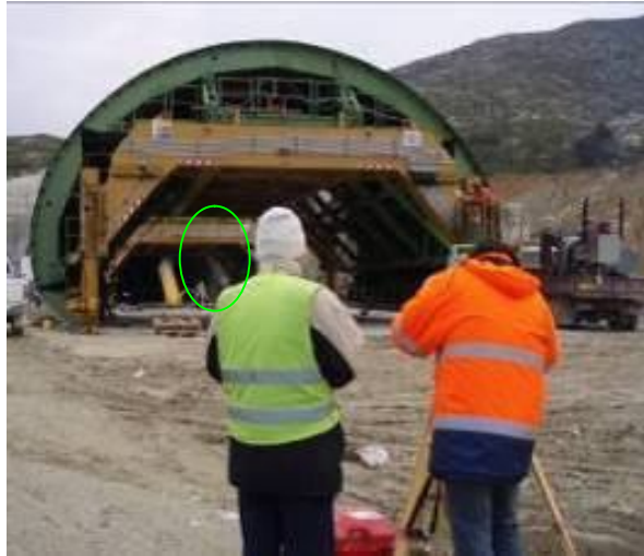
Σχήμα 2.23: Ταυτόχρονος γεωμετρικός έλεγχος μεταλλότυπου και στα δύο άκρα του Figure 2.23: Simultaneous geometric control of the metal formwork at its both ends
