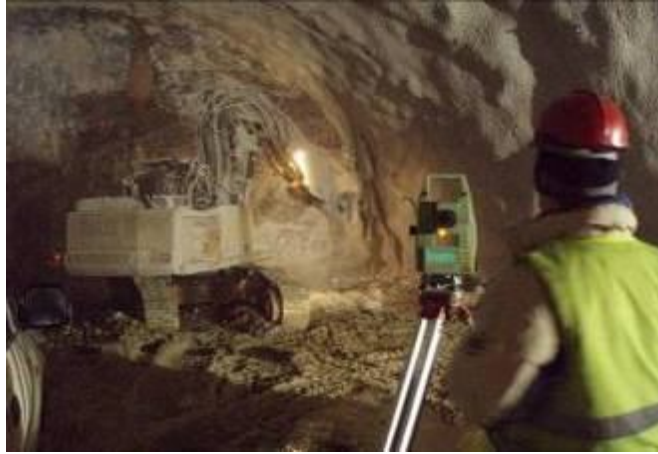
Σχήμα 2.18: Έλεγχος της διατομής εκσκαφής
