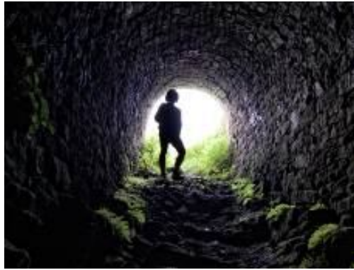
Σχήμα 1.1: Είσοδος μεταλλευτικής σήραγγας
