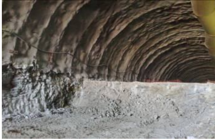
Σχήμα 1.12: Εκσκαφή σήραγγας σε δύο φάσεις
