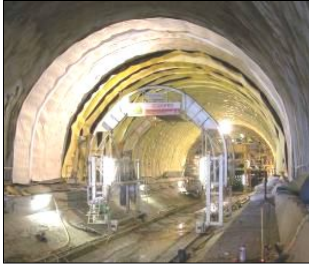
Σχήμα 4.5: Τοποθέτηση αποστραγγιστικής μεμβράνης
