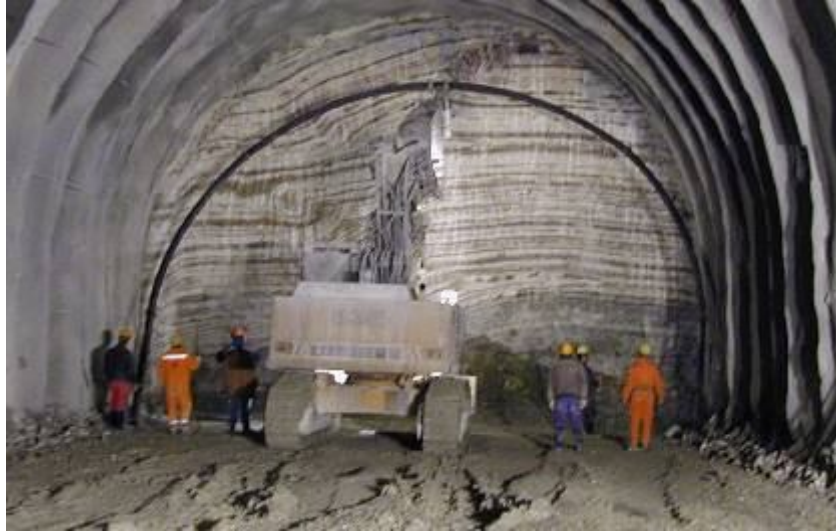
Σχήμα 1.28: Τοποθέτηση χαλύβδινου πλαισίου
