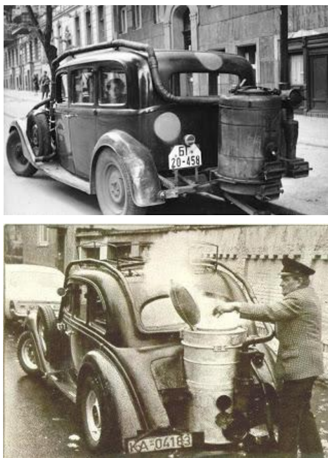
Σχήμα 1.4: Φωτογραφίες αυτοκίνητων εποχής Β' Παγκοσμίου Πολέμου, με τεχνολογία αεριοποίησης ξύλου [11].
