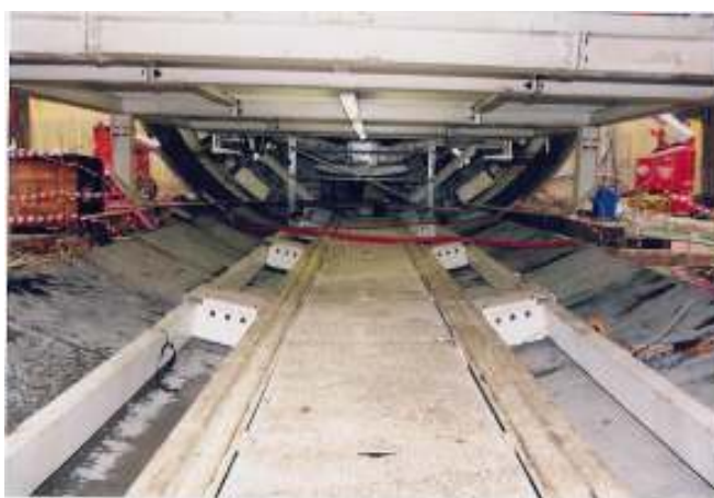
Εικόνα 13 Τροφοδοτικός μεταλλικός διάδρομος προκατασκευασμένων στοιχείων
