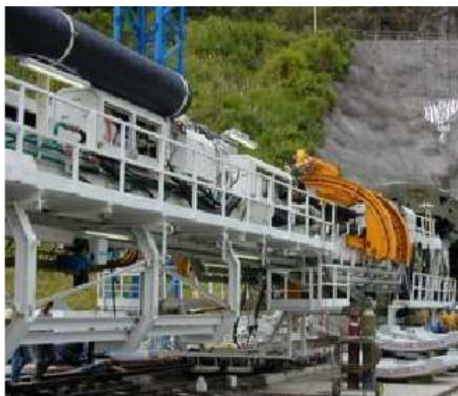
Εικόνα 15 Σύστημα υποστήριξης TBM
