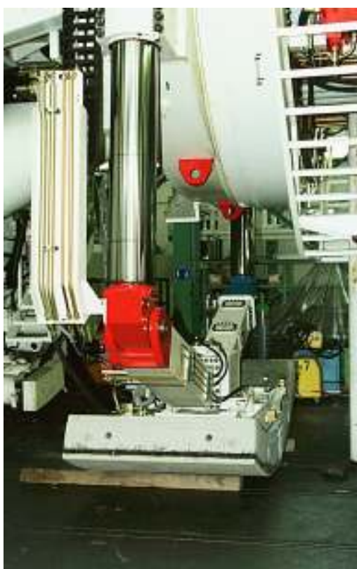
Εικόνα 12 Ανελκυστήρας για την τοποθέτηση των στοιχείων
