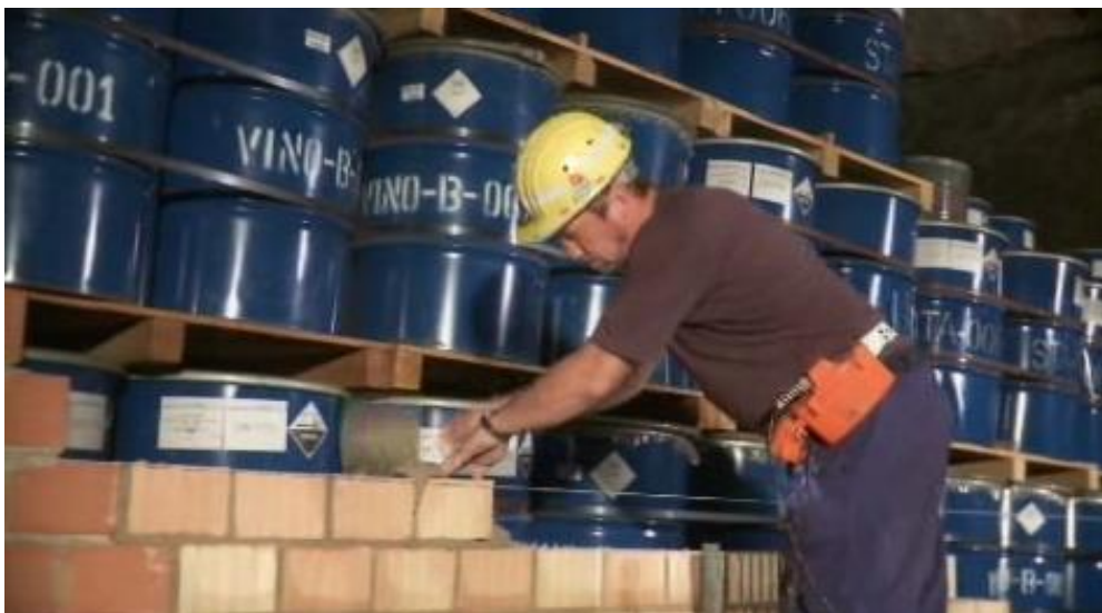
Εικόνα 31 Εργασίες κατασκευής της πλινθοδομής από εξειδικευμένο προσωπικό της εταιρείας. Πηγή: K+S Entsorgung GmbH, 2016
