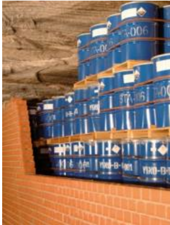
Εικόνα 30 Χαρακτηριστικοί πλινθοδομή της εγκατάστασης που θα σφραγίσει για καιρό τα επικίνδυνα απόβλητα Πηγή: K+S Entsorgung GmbH, 2016
