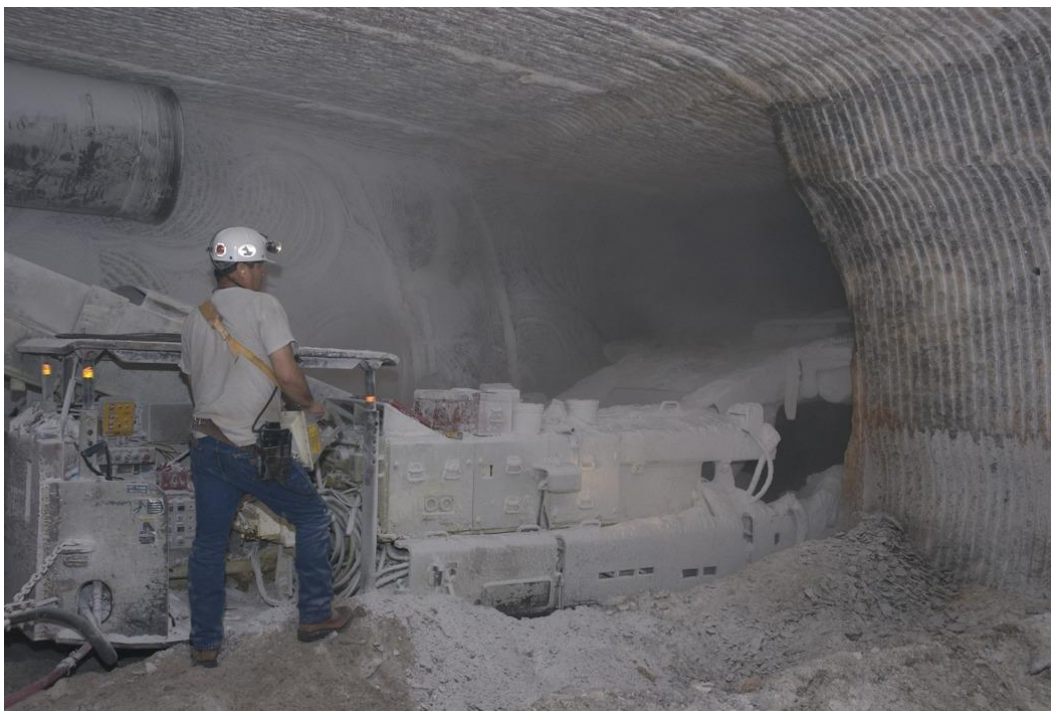
Εικόνα 13 Εργασίες εξόρυξης στο W.I.P.P. για τη διάνοιξη των ανοιγμάτων στο σχηματισμό του ορυκτού άλατος. Πηγή: The US Department of Energy, 2015
