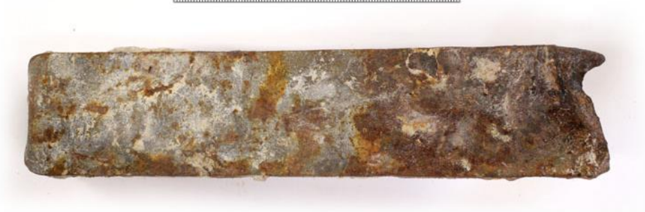
Εικόνα 4.1.18: Σύνδεσμος Σ.245 όψη Δ'.
