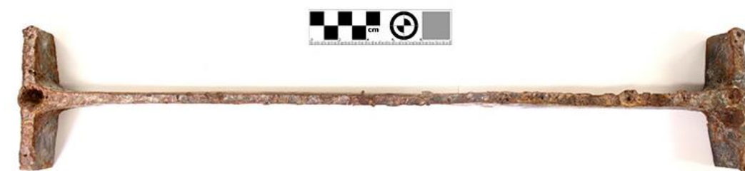
Εικόνα 4.1.10: Σύνδεσμος Σ.214 όψη Γ'.
