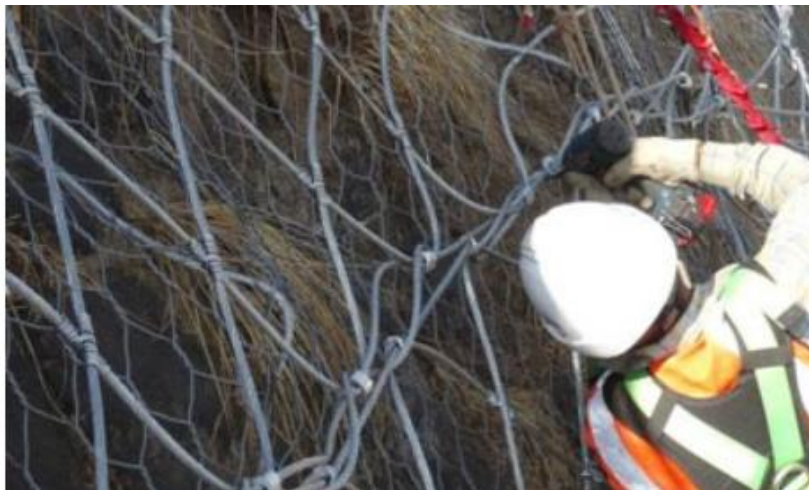
Εικόνα 2.31: Προστασία πρανούς με χρήση δακτυλιοειδούς πλέγματος (Εικόνα από “maccaferri.com”)
