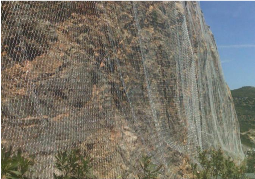
Εικόνα 2.30: Προστασία πρανούς με χρήση ελεύθερου πλέγματος (Εικόνα από “plastwood.gr”)
