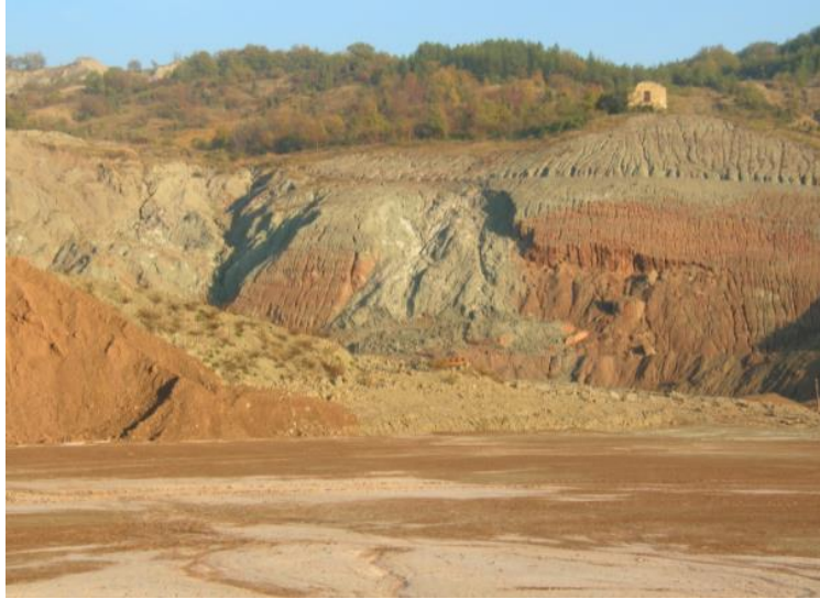
Εικόνα 2.15: Ολισθήσεις γαιών σε αργιλώδεις σχηματισμούς λόγω της εκμετάλλευσης του λατομείου Roncobotto (Castaldini)
