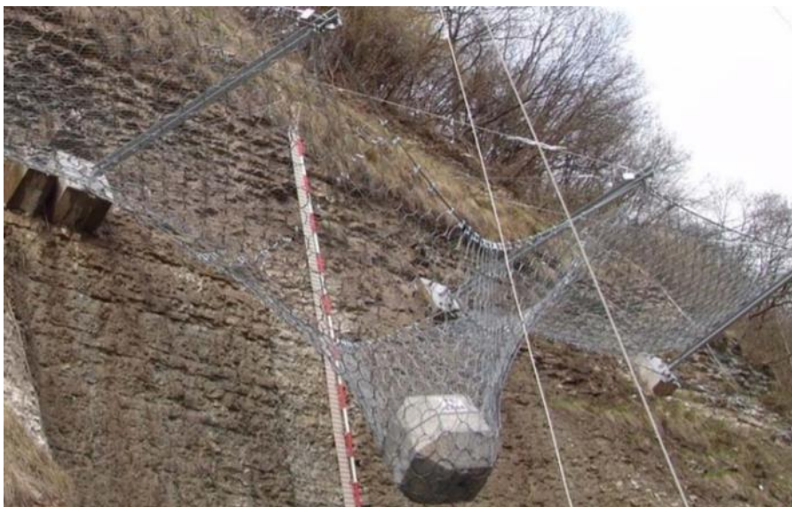
Εικόνα 2.29: Συγκράτηση κινούμενου αποκολλημένου βράχου από φράχτη ανάσχεσης (Εικόνα από “maccaferri.com”)
