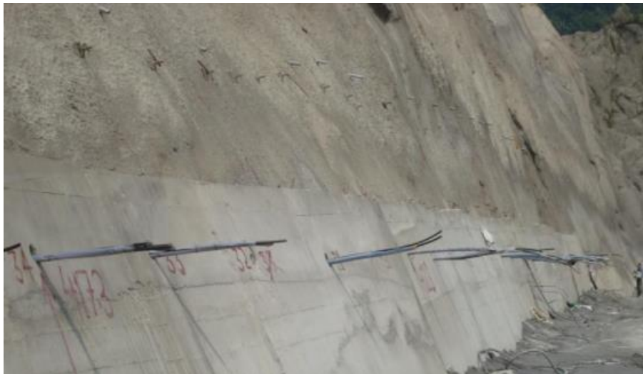
Εικόνα 2.24: Αγκυρωμένος τοίχος (Εικόνα από το “pinterest.com”)
