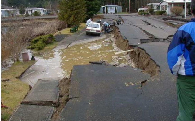
Εικόνα 2.6: Εγκάρσιες εξαπλώσεις (lateral spreads) στη λίμνη Sunset (Kramer, 2001)
