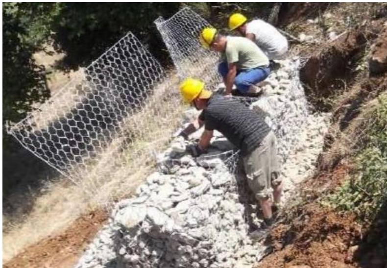
Εικόνα 2.18: Αποκατάσταση ζημιών πρανούς στην επαρχιακή οδό Ραψάνη, Λάρισα (Εικόνα από “paidis.com”)
