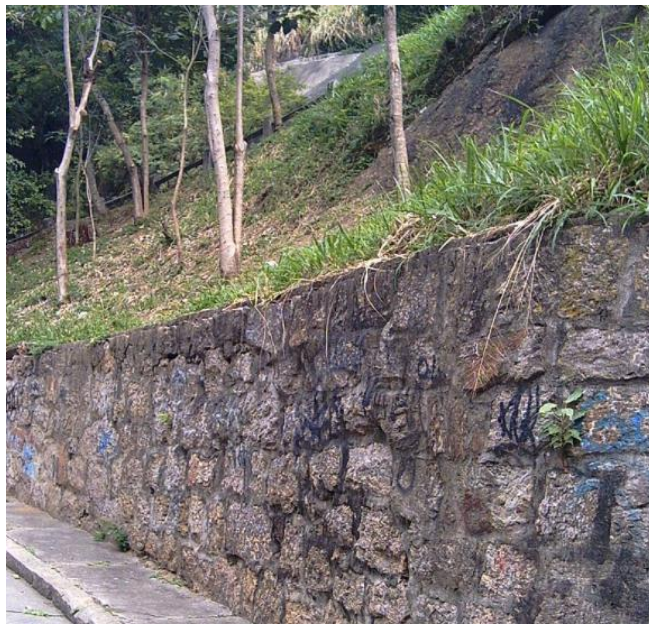
Εικόνα 2.22: Τοίχος αντιστήριξης βαρύτητας (Εικόνα από “wikipedia.org”)
