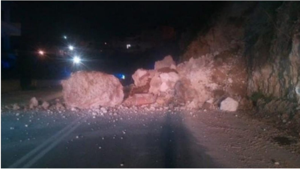
Εικόνα 2.12: Πτώση και ροή βραχωδών τεμαχίων στην εθνική οδό Ναυπάκτου - Ιτέας (Εικόνα από “nafraktianews.gr”, 2021)
