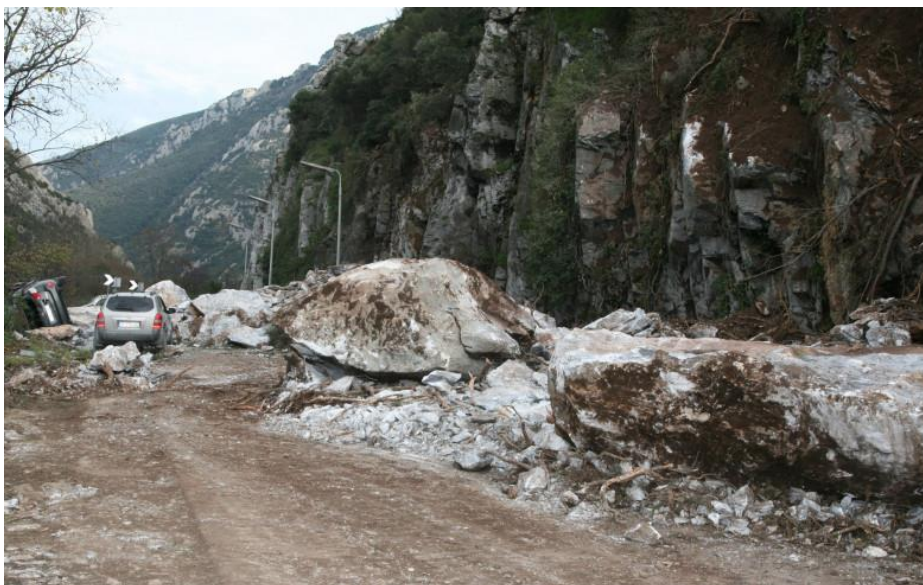
Εικόνα 2.2: Καταπτώσεις βράχων (rockfalls) στα Τέμπη (Εικόνα από "skai.gr", 2009)
