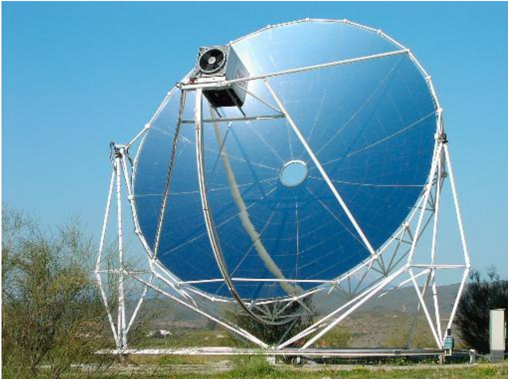
Σχήμα 3.5.22: Δίσκος πλήρους παραβολοειδούς επιφάνειας της Eurodish (Πηγή: http://www.volker-quaschning.de )
