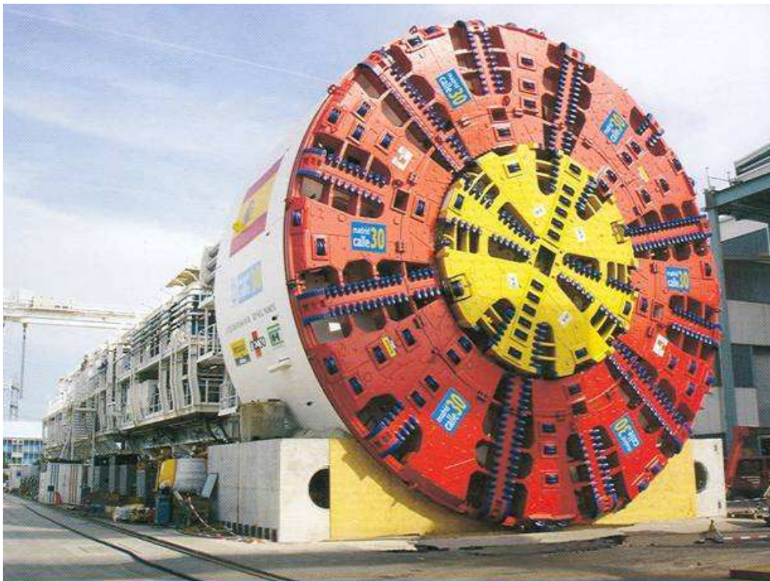
Εικόνα 3.5.2.1 Το μεγαλύτερο TBM EPB διαμέτρου 15.20 m για την κατασκευή αστικού αυτοκινητοδρόμου στη Μαδρίτη
