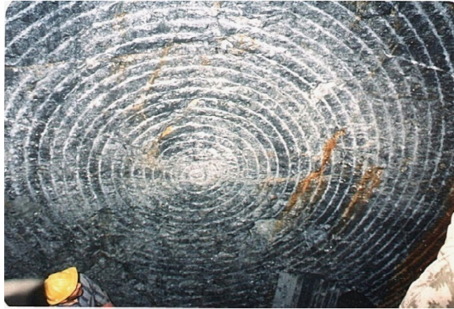
Εικόνα 3.7.2 Κοπή πετρώματος με κοπτικά δίσκου
