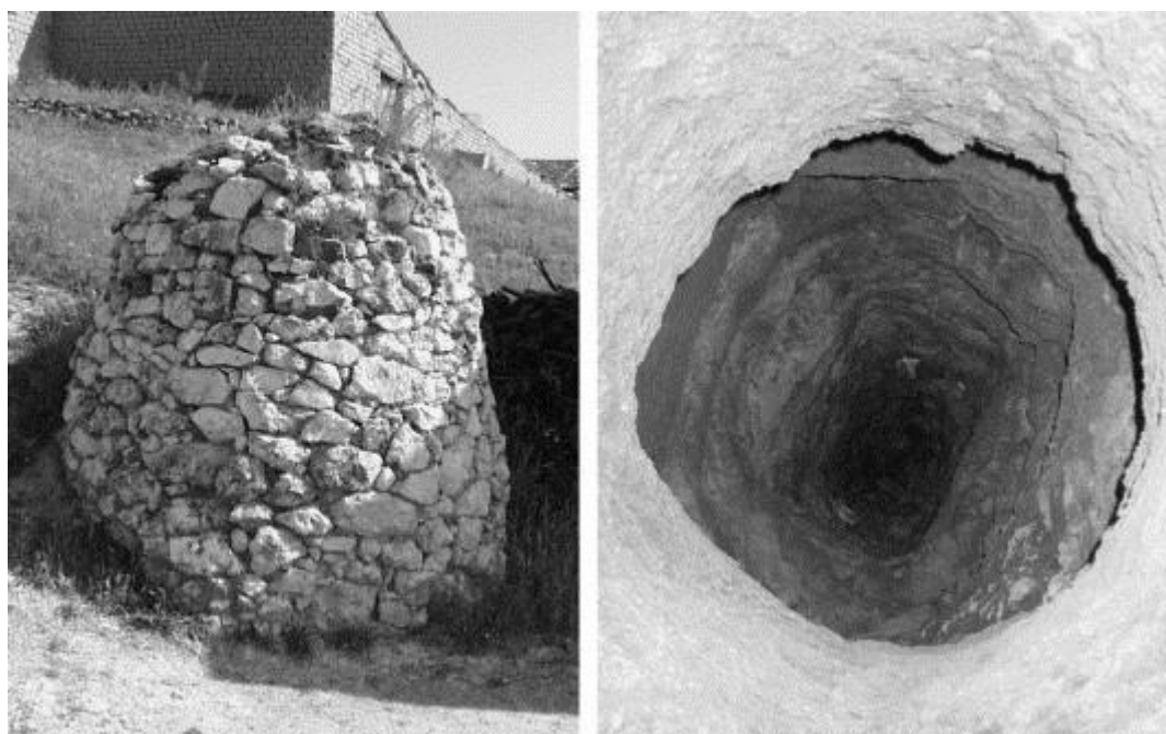
Εικόνα 2.24: Εξωτερική και εσωτερική όψη μίας καμινάδας εξαερισμού ή zarcera .
