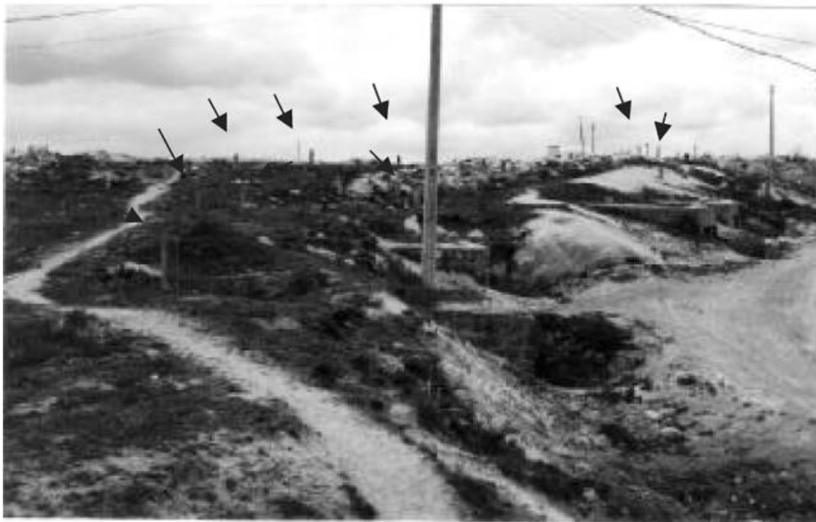
Εικόνα 2.3: Επιφανειακή θέα με τους σωλήνες εξαερισμού των υπόγειων χώρων.
