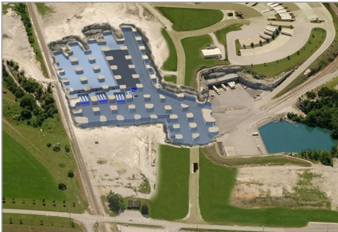
Εικόνα 2.29: Τοποθεσία υπόγειου χώρου Springfield.
