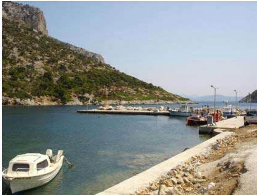
Εικόνα 3.1 Αλιευτικό καταφύγιο Γέρακα Πηγή (Στεργιούλη, 2006)
