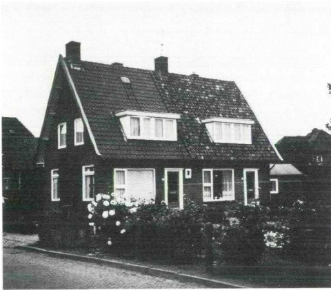
Woningen Landaasweg nummers 5 en 7 (verbouwde limonadefabriek 'De Woude', eigendom van de Roomboterfabriek 'De Vooruitgang'. Bewoners: de familie J. van Grootheest en de familie D. van Voorthuizen).
