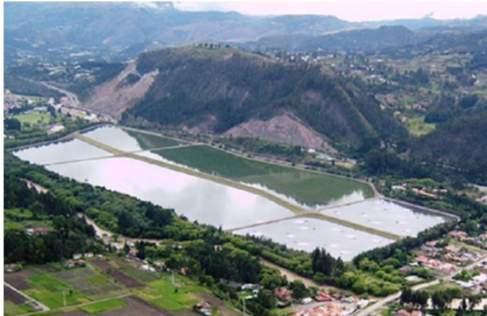
Figura 5: PTAR de Ucubamba.
