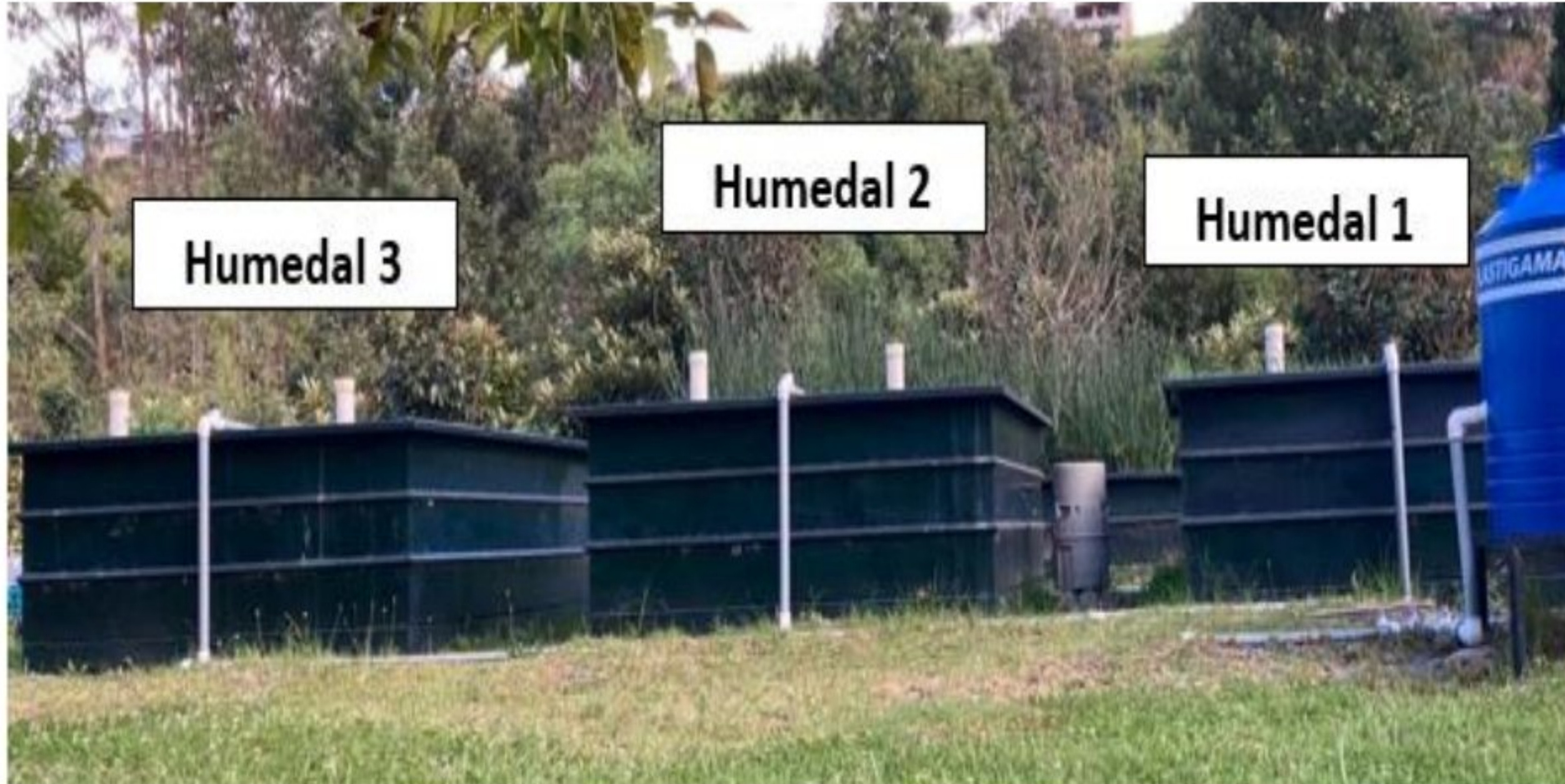
Figura 9: Humedales dispuestos en paralelo.
