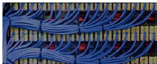
Figura 3.6: Cableado Horizontal
