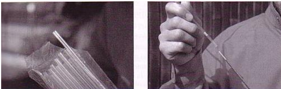
Pose de la gaine.....
