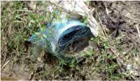
Photo G. Exemple de grille non efficace à l'arrivée d'eau d'un étang (Libéria) [© Y. Fermon].
