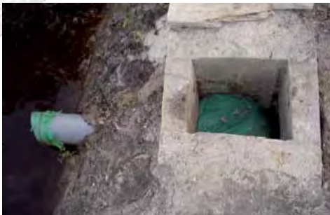
Photo H. Exemple de filtre mis en place à la prise d'eau d'un étang au Libéria [© Y. Fermon].
