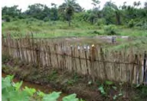
Photo M. Mise en place d'une clôture en branchage (Libéria) [© Y. Fermon].
