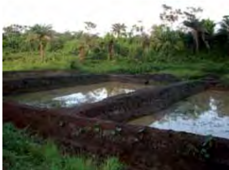
Photo B. Exemple d'étangs rectangulaires en construction disposés en parallèle (Libéria) [© Y. Fermon].
