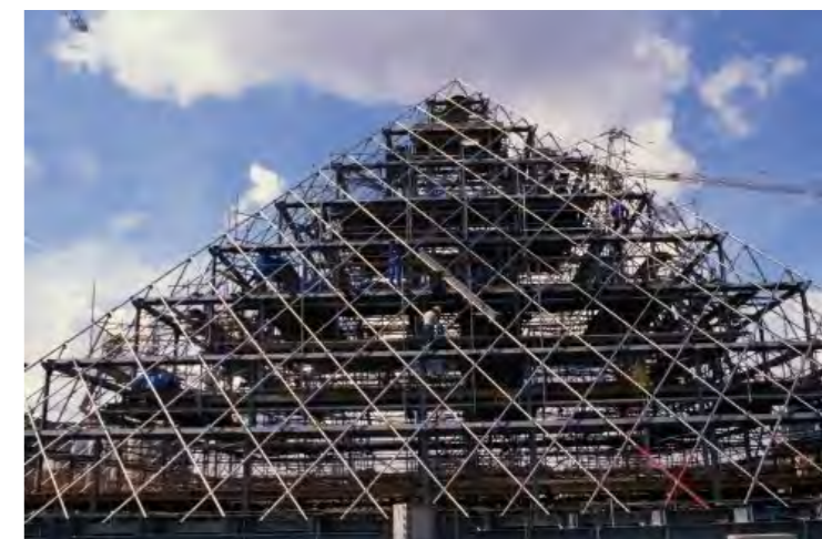
fig.34 : Photographie de la pyramide en construction
