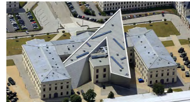
fig.133 : Photographie aérienne de l'arrière du projet
