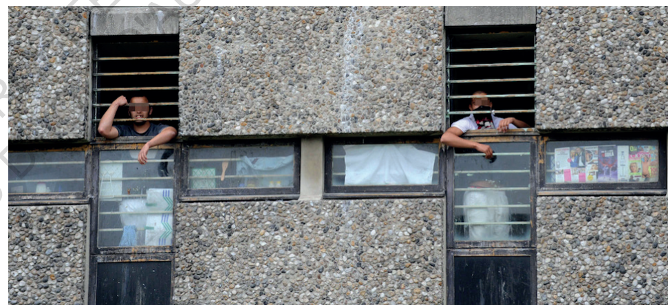
Ouverture des cellules en forme de croix, des barreaux ont été rajoutés. Philippe Lopez photographe.
