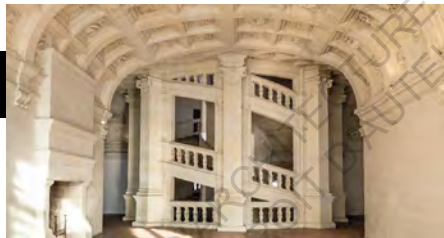
Fig 11 : Escalier à double révolution du château de Chambord
