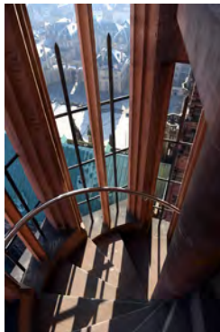
Fig 8 : Escalier à vis de la tour de la flèche de la cathédrale de Strasbourg
