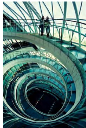
Fig 27 : Escalier hélicoïdal de l'hôtel de ville de Londres
