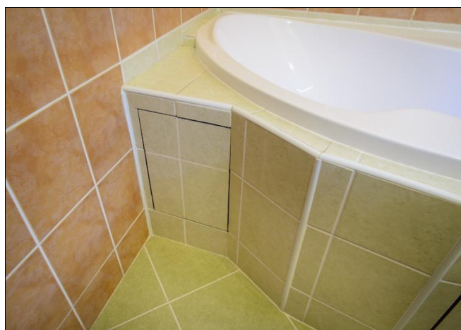
Maskovanie filtračného systému pod obmurovaním vane.
