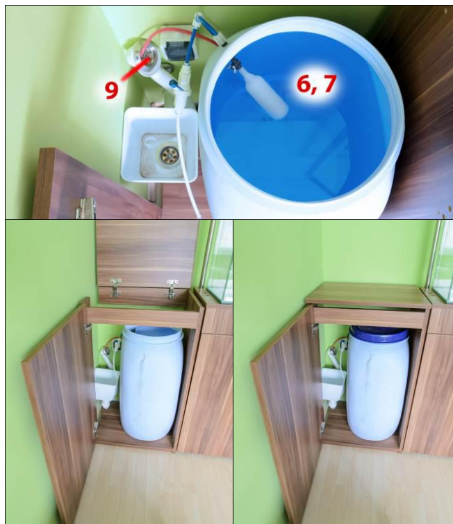
Umiestnenie zásobníka na čistú vodu v obývacej izbe, vedľa skrinky s akváriom.
