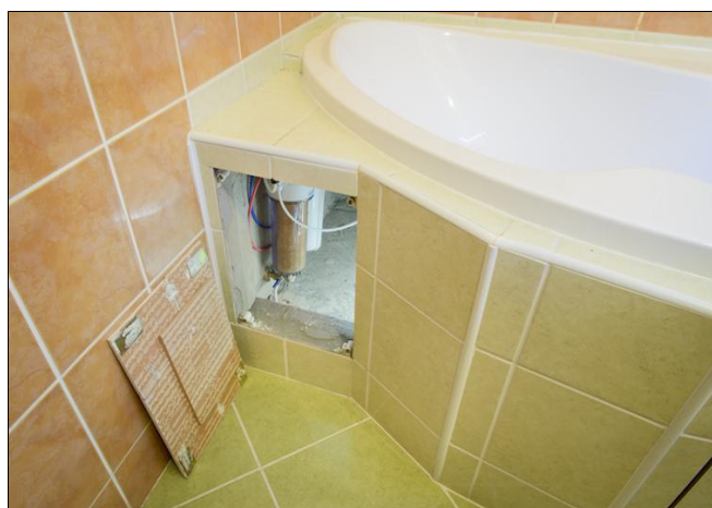
Filtračný systém je umiestnený do slepého priestoru pod vaňou, ktorý vznikol jej obmurovaním.
