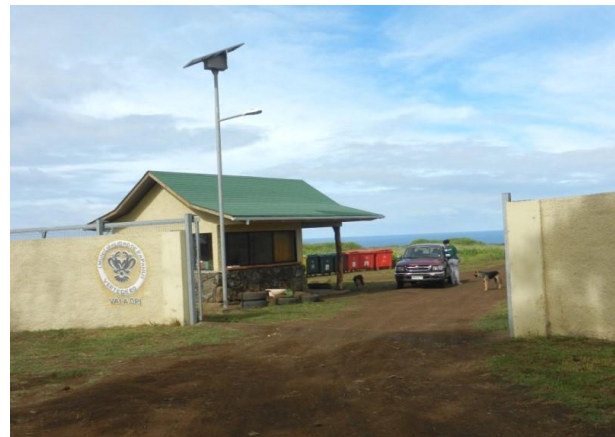
Figura 41: Control de acceso y registro vertedero Vai a Ori.
