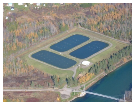
Site de traitement des eaux usées de Bonaventure
