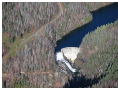
Barrage hydroélectrique de la rivière Hall
