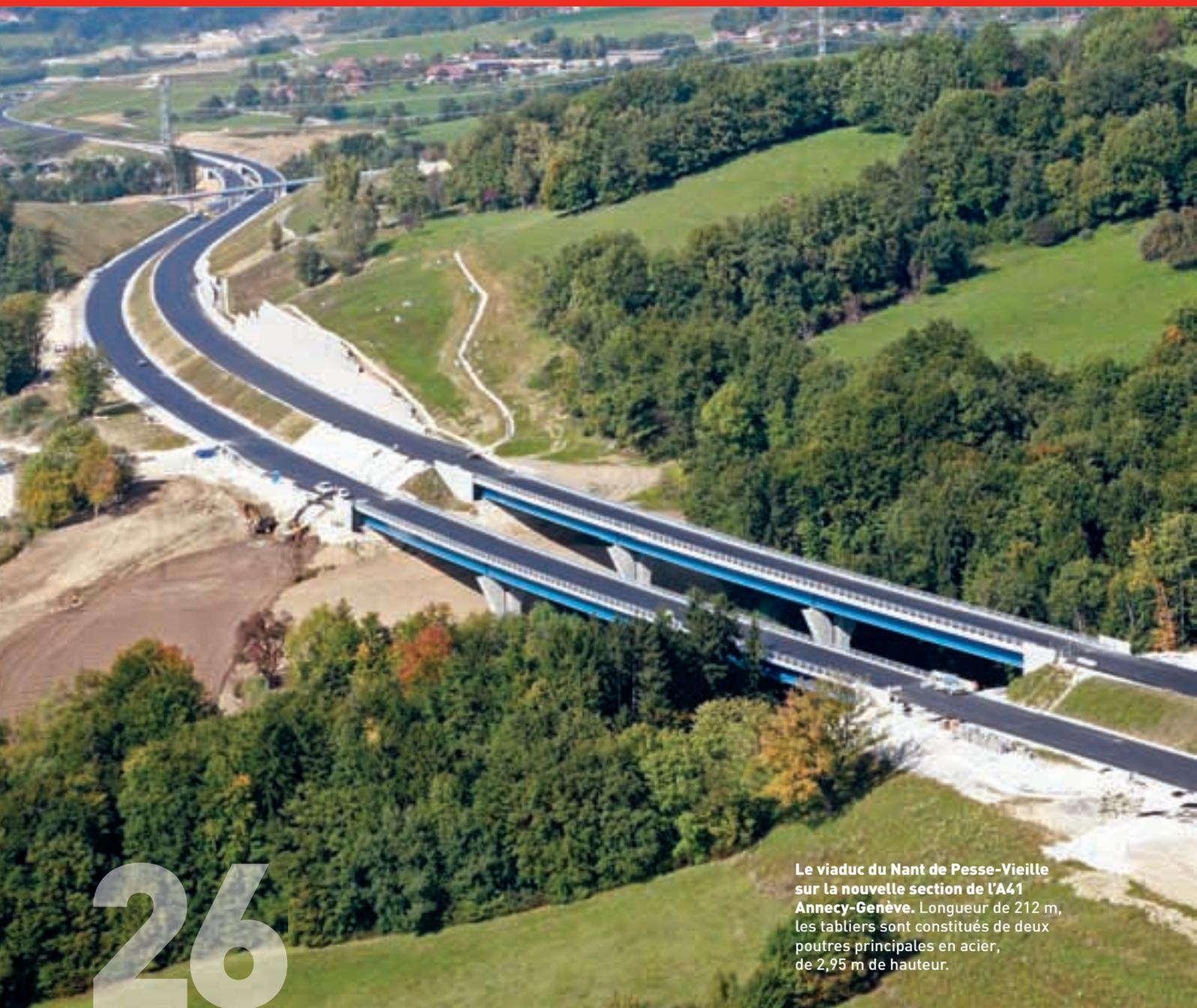
**Le viaduc du Nant de Pesse-Vieille sur la nouvelle section de l'A41 Annecy-Genève.** Longueur de 212 m, les tabliers sont constitués de deux poutres principales en acier, de 2,95 m de hauteur.
