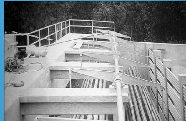
Διάταξη παλινδρομικής ανάδευσης με κουπιιά
