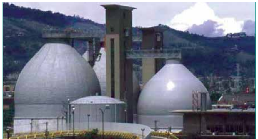
Fig.1: Anaerobic digesters at Empresas Publicas
