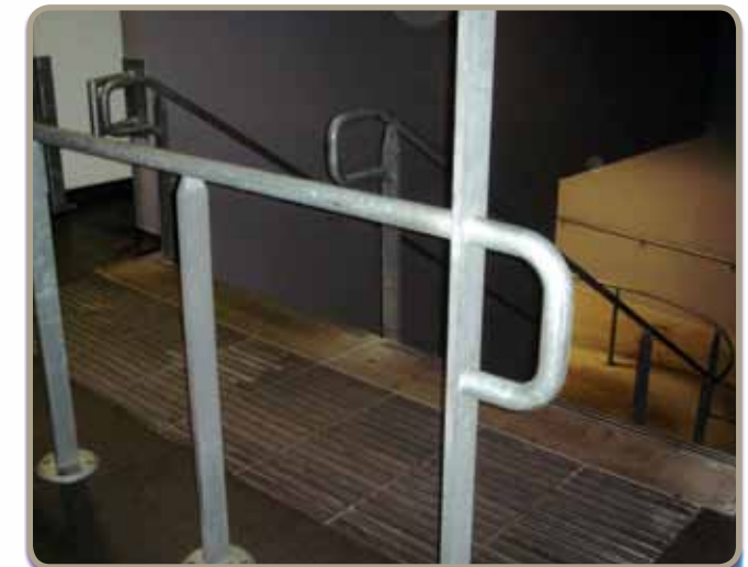
Ilustración 16: Pavimento táctil (indicación detectable) con una barrera en lo alto de las escaleras
