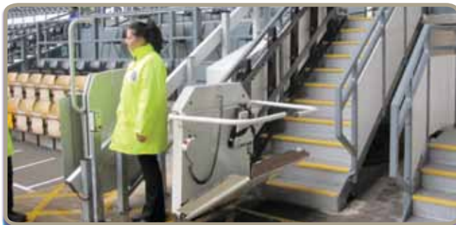
Figura 12 –Lift pentru scară deschis, extern, la Pride Park, Derby County FC, Anglia
