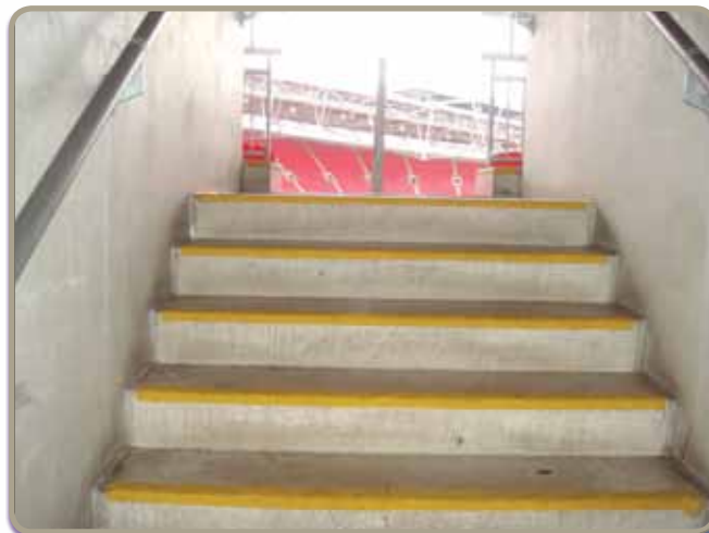
Figura 15 –Scară cu trepte uniforme, două balustrade și buza treptei în culoare contrastantă
