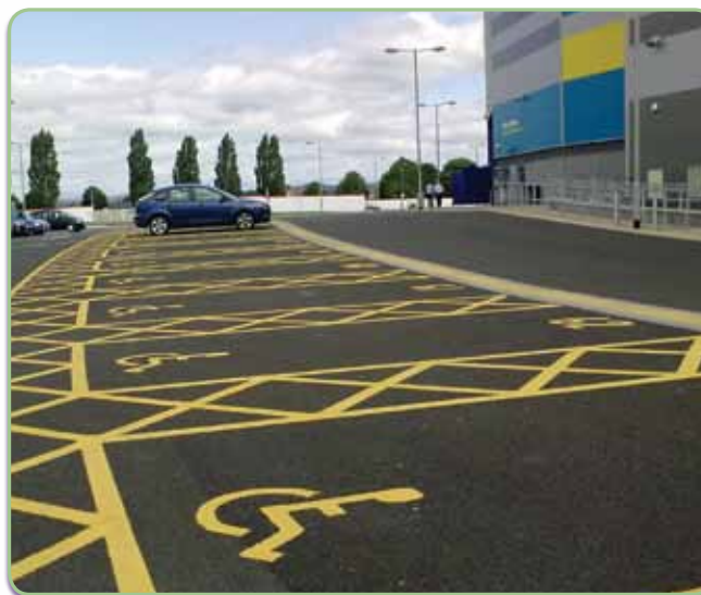
Figura 2 – Parcarea accesibilă la noul Cardiff City Stadium, Țara Galilor
