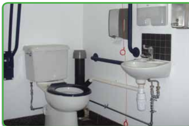
Figura 24 –Exemplu de toaletă accesibilă
