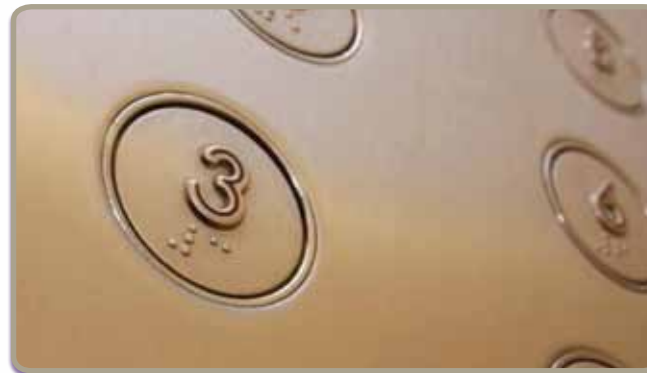
Figura 11 - Un panou de control al liftului cu simboluri tactile și Braille
