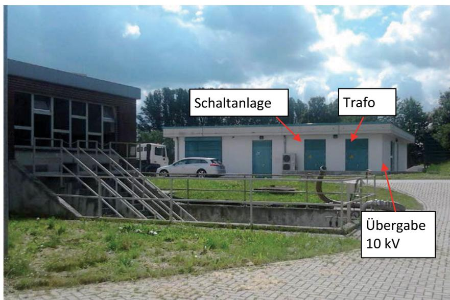
Abb. 15: Lage der Stromversorgungsanlagenkomponenten auf der Kläranlage Hünxe
