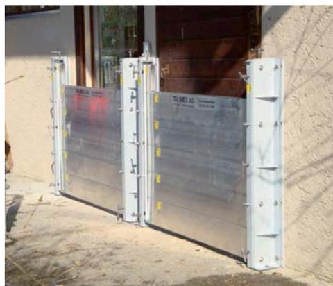
Abb. 23: Prinzipskizze und Beispiel eines Dammbalkensystems [Köngeter, 2002; Blobel, o.J.]
