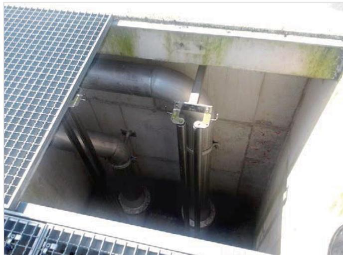
**Abb. 18:** Ausgebaute Hochwasserpumpe und Führungsschiene zum Einbau im Hochwasserpumpwerk
