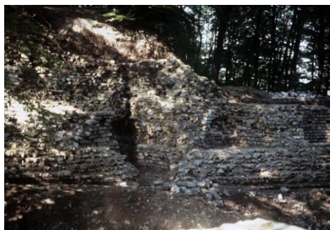
Foto 5, südl. Entlastungsbogen E 3, deutlich sichtbar ist der Ausbruch im Vordergrund und der tiefe Spalt in der Rückseite des Bogens/von MR6.
